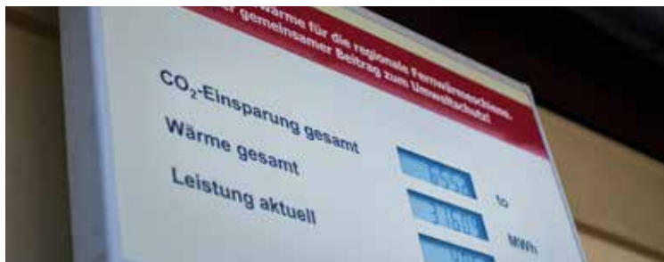
Utilizzo dei cascami termici per la rete regionale di teleriscaldamento
