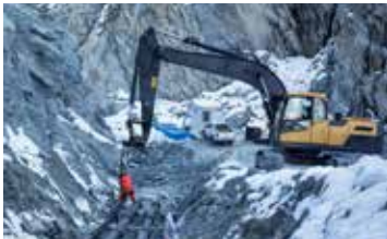
Condotte per innevamento e alta pressione
