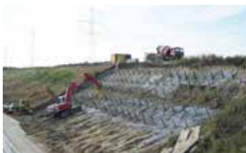
Stabilizzazione dei pendii
