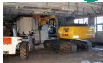
Rinforzo fondazioni con altezza di lavoro limitata
