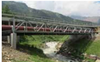
Tubazioni per il passaggio di ponti
