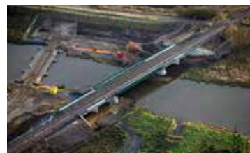
Costruzione di ponti
