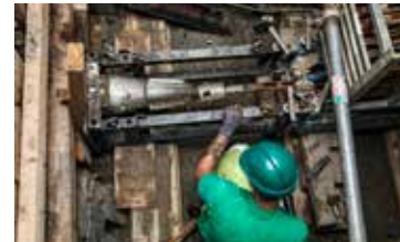
Metodo di posa senza scavo
