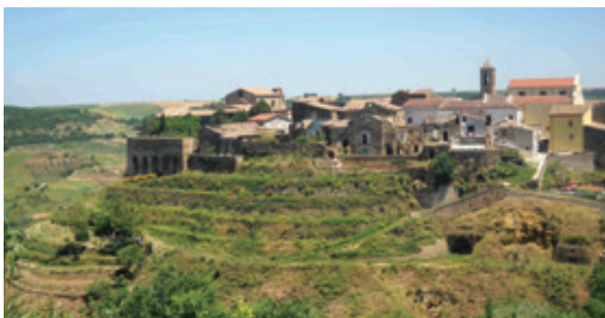
Lavori di manutenzione straordinaria e consolidamento dei costoni a Genzano di Lucania (PZ).
