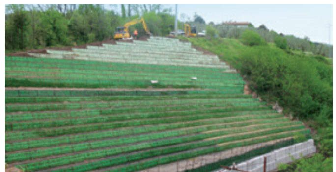
Ripristino pendio franato in località Serravalle Pistoiese (PT) sulla linea ferroviaria Firenze-Lucca.
