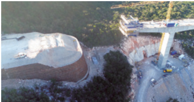
Spalla di ponte, Peljesac Bridge, Croazia.
