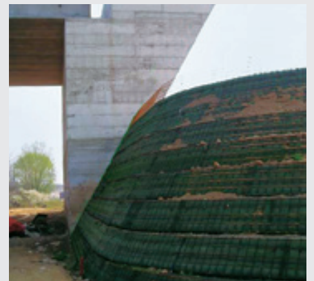
Particolare dell'angolo di raccordo della terra rinforzata con strutture già esistenti in cemento armato.
