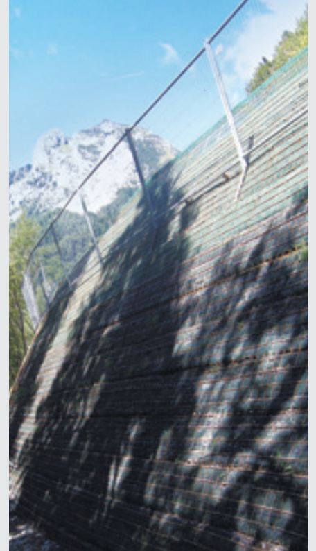
Parapetto in accordo alle normative di sicurezza in cantiere.
