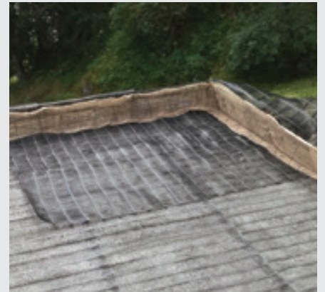
Realizzazione di angoli e curvature.
