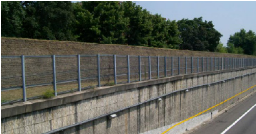
Intervento sulla tangenziale A51 di Milano per la realizzazione di una barriera antirumore con Terre Rinforzate a paramento rinverdito necessaria per la protezione delle abitazioni confinanti. L'opera si sviluppa per 300 m in lunghezza e 3 m circa in altezza.
