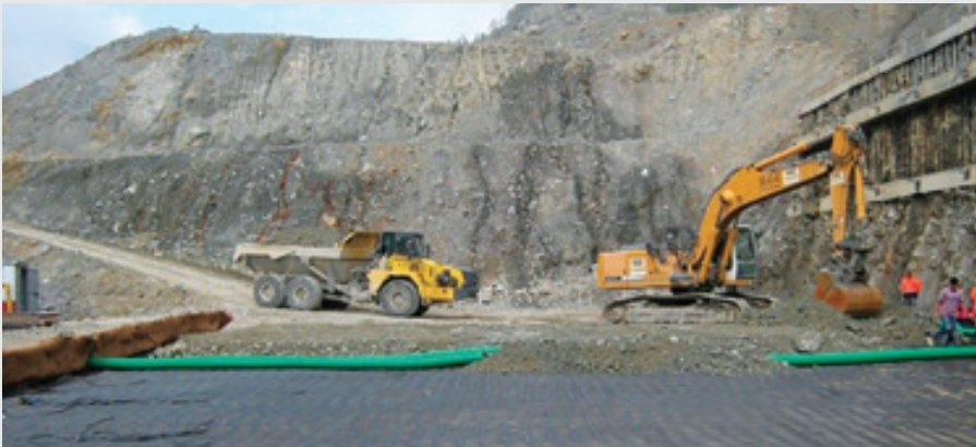
Posizionamento di tubazioni per il drenaggio.
