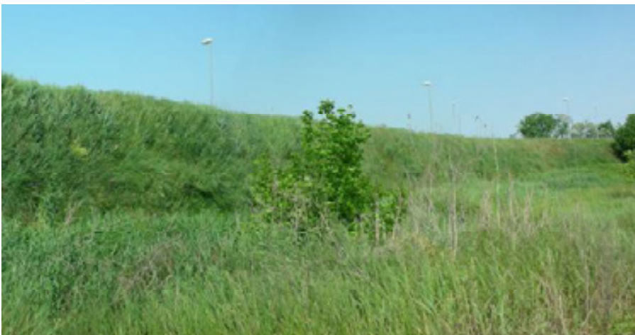
Lavori di completamento della Tangenziale Nord di Pavia, dall'innesto con la Tangenziale Ovest allo svincolo con la S.P.2 "Melegnanina". Realizzazione di 400 ml di duna antirumore e muri d'ala con Terre Rinforzate a paramento rinverdito per complessivi 2500 m 2 di facciata a vista.
