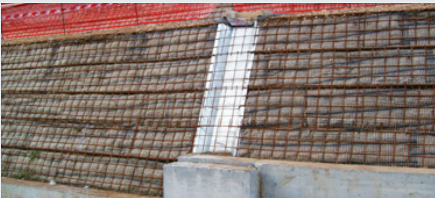
Posizionamento degli embrici metallici per il deflusso delle acque superficiali.
