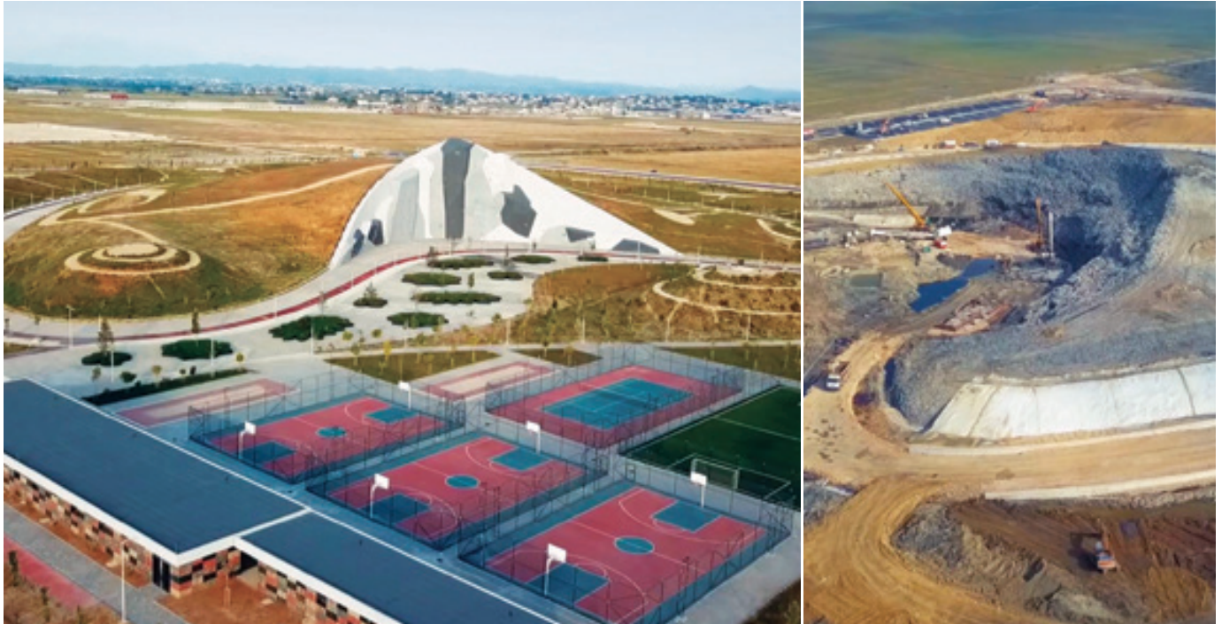
Ecopark Durazzo: argine in terra rinforzata di 21 m di altezza per riduzione spinte su muro da arrampicata sportiva con altezza di 28 m.
