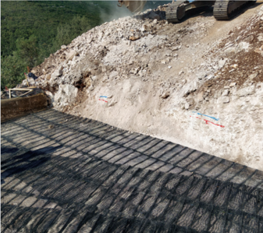
Le geogriglie vengono sovrapposte in testa o in coda a seconda che il tratto sia concavo o convesso.
