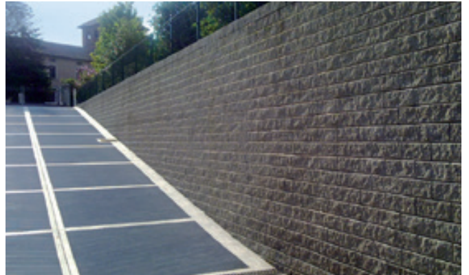
Raccordo con rampa.
