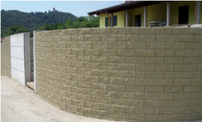
Realizzazione tratti curvi.
