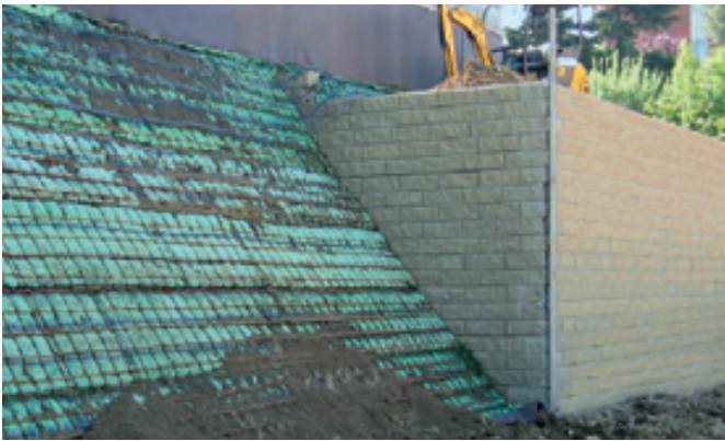
Raccordo con terre rinforzate.
