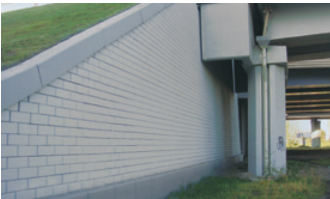
Raccordo con strutture in c.a.
