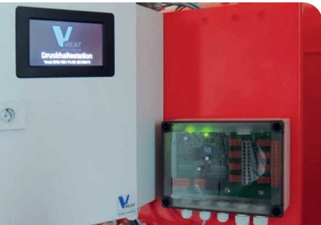
← Steuerung mit Touch Display und dem Zusatzmodul RS4 IO/TV
